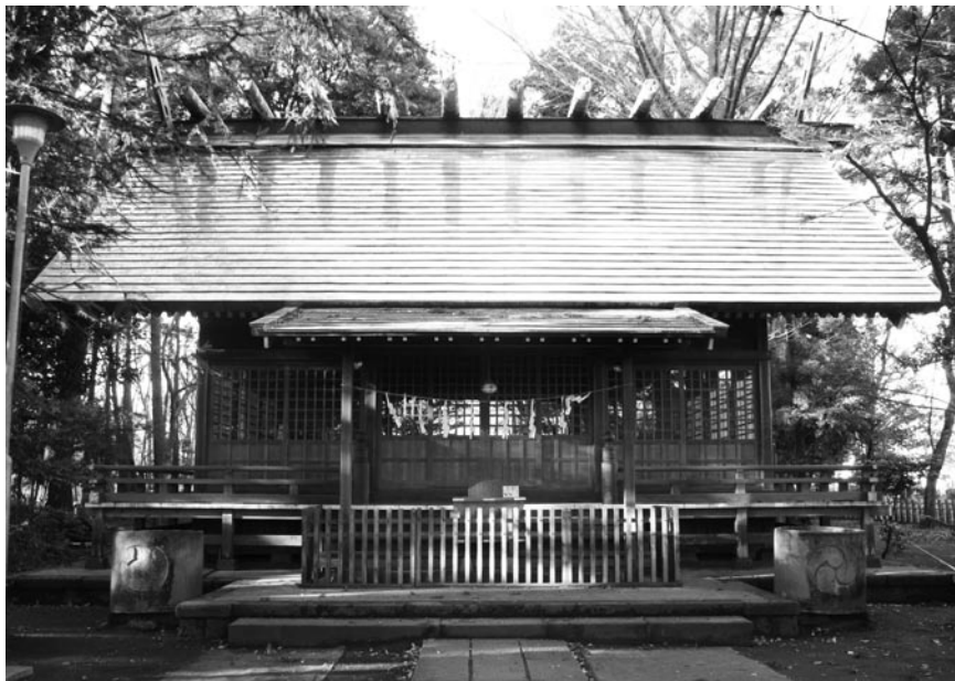
ここ数年来、雨漏りがしていた拝殿の屋根の張り替えを行いました。
